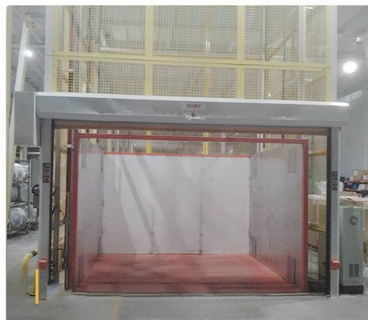
工厂物料提升项目
